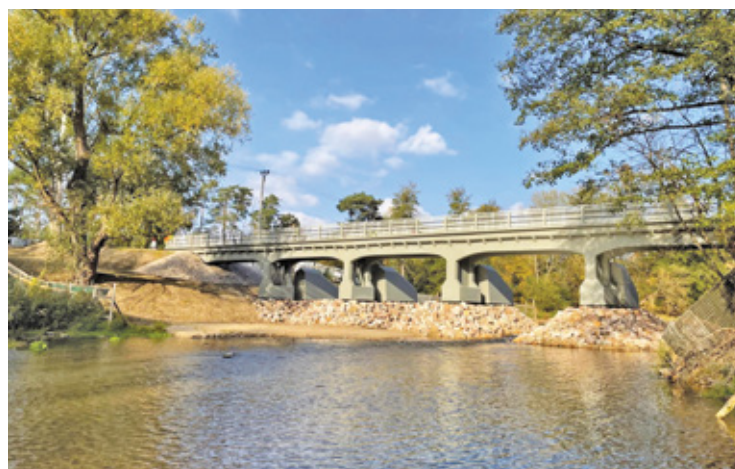
Remont jest już na końcowym etapie
