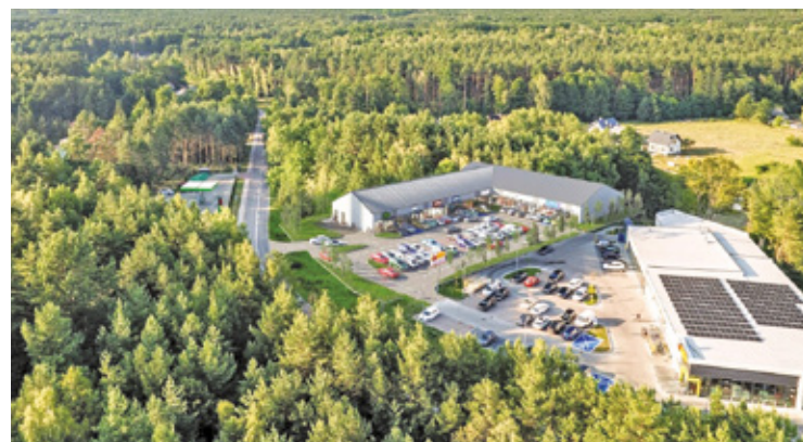
Budowa nowego obiektu handlowego jest już na końcowym etapie
