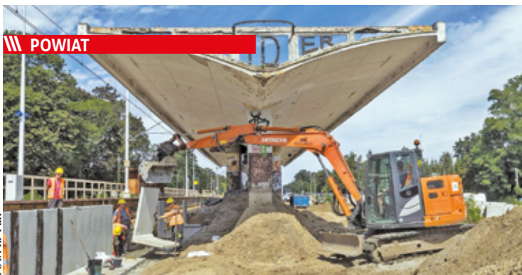
FOT. PRP PLK Wykonawca pracuje jednocześnie przy kilku przystankach między Wawrem a Otwockiem
