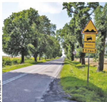
MZDW sukcesywnie modernizuje kolejne odcinki Nadwiślanki
