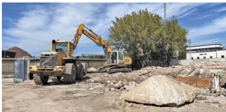
Przy dworcu w Otwocku zniknęły stare budynki z rampą kolejową
