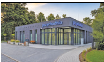
/// Wiązowna - Przebudują drogę do przychodni s. 6
