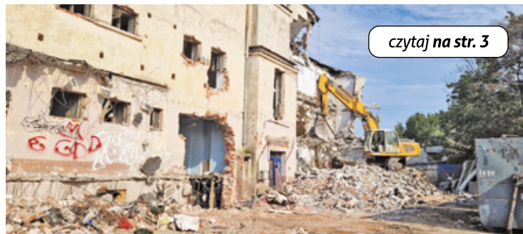
czytaj na str. 3 Pierwszy etap inwestycji obejmuje porządkowanie terenu i wyburzenie starych budynków
