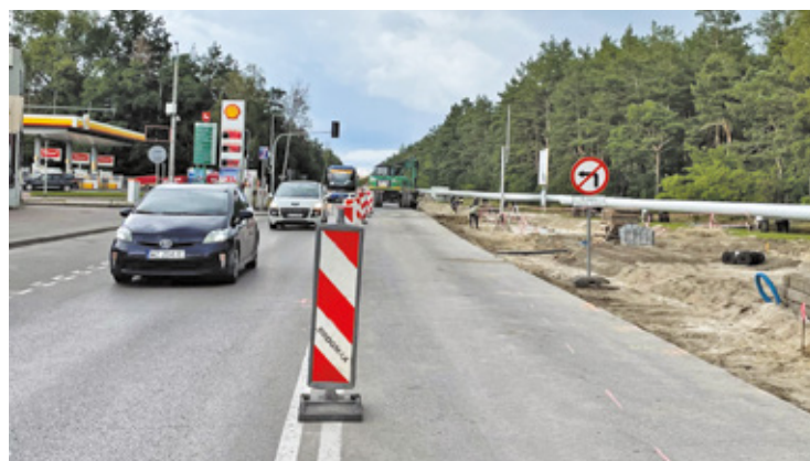
Ruch na remontowanym odcinku ul. Mickiewicza odbywa się wahadłowo
