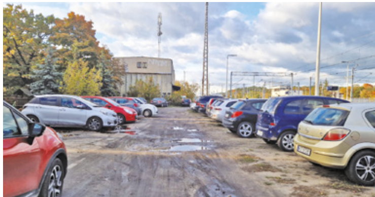
Kierowcy korzystają dziś z dzikiego parkingu przy torach. W ramach inwestycji teren zostanie przebudowany
