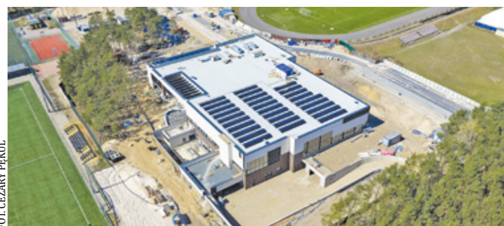
Jedną z najważniejszych inwestycji jest budowa kompleksu basenowego przy ul. Karczewskiej
