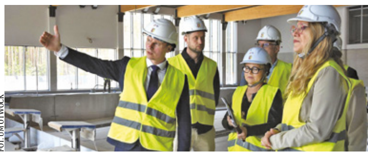
Podczas wizyty w Otwocku ambasador Grecji Niki Kamba obejrzała budowę kompleksu basenów
