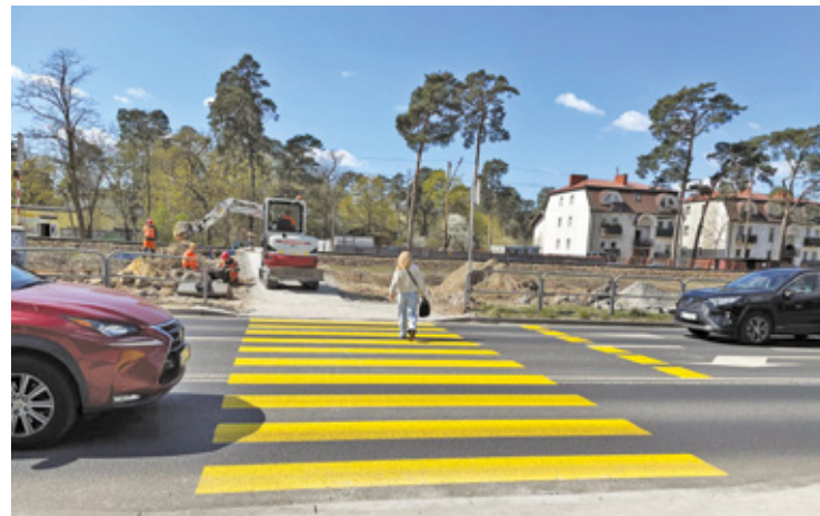
Wykonawca przygotowuje tymczasową infrastrukturę przy modernizowanej linii kolejowej
