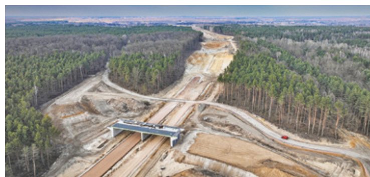
Tak wygląda plac budowy obwodnicy Kołbieli z lotu ptaka
