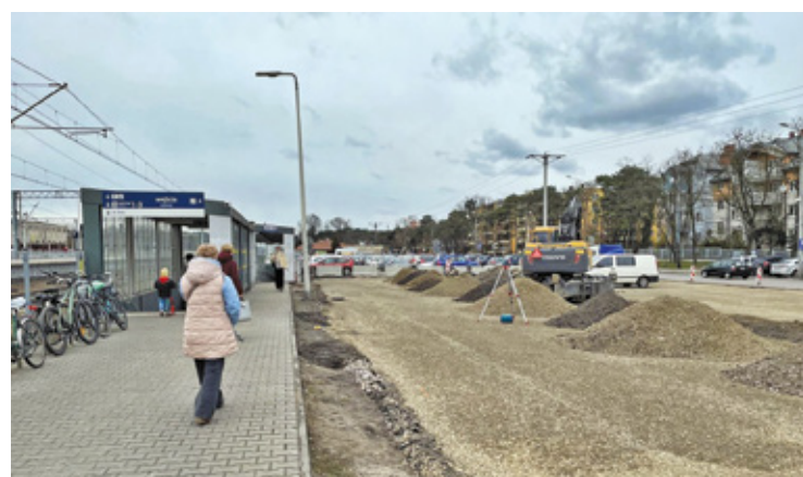
Przy PKP Otwock trwa budowa tymczasowej pętli dla autobusowej komunikacji zastępczej
