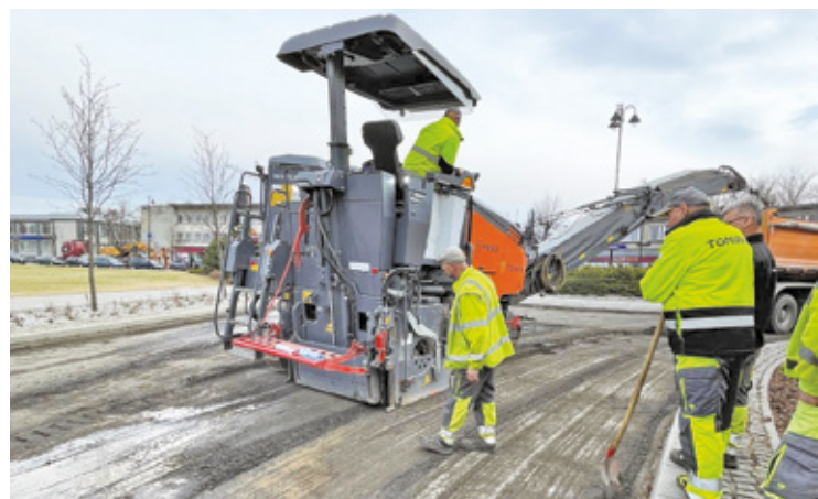
Remont ul. Staszica obejmuje nie tylko jezdnię, ale również modernizację ronda
