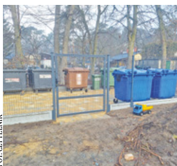
Teraz w tym miejscu zrobiono nowy, zamknięty boks na odpady
