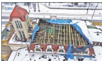
/// Otwock - Remont dworca za 22 mln złotych s. 2
