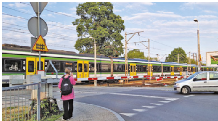
Na czas robót w wielu miejscach powstaną tymczasowe perony i przejścia przez tory
