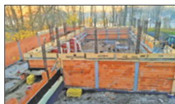
/// Rudzienko – Powstaje sala sportowa s. 9
