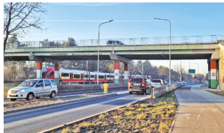
Trasa „721” wraz z wiaduktem drogowym będzie jedną z ulic, którą będzie można ominąć utrudnienia wzdłuż modernizowanej linii kolejowej
