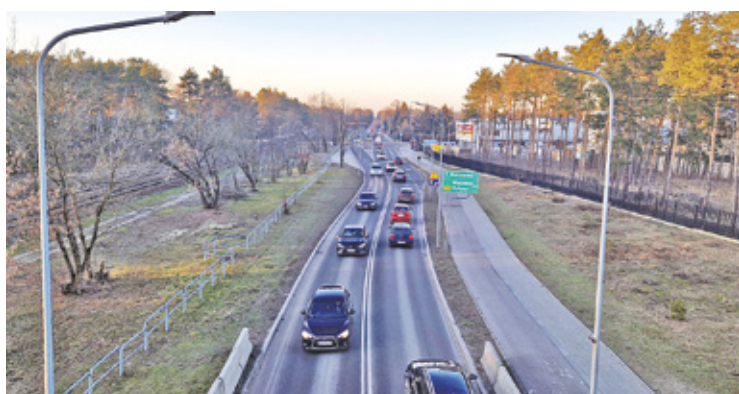
Mazowiecki Zarząd Dróg Wojewódzkich od dawna planuje zburzenie starego wiaduktu i budowę nowego
