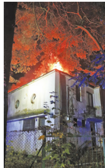
Pożar budynku przy ul. Syrokomli w Otwocku-Śródborowie
