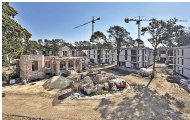
FOT. MATERIAŁY INWESTORA
