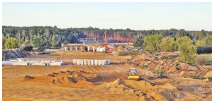
Obecnie widać już zarys przyszłej trasy
