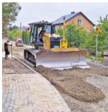
Nowa asfaltowa droga będzie przejezdna za kilkanaście dni
