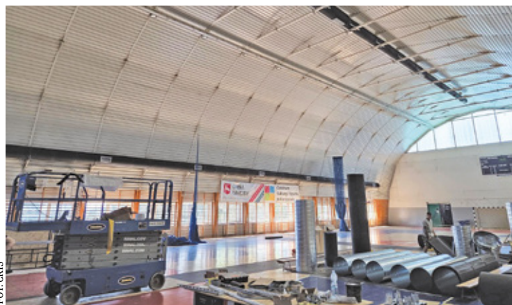
Trwają prace modernizacyjne w hali sportowej Centrum Kultury i Sportu przy ulicy Bohaterów Westerplatte
