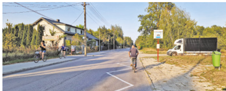
Od kilku lat władze powiatowe planują przebudowę tego odcinka ul. Narutowicza
