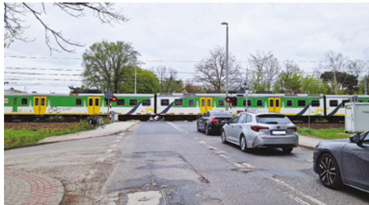
Tunel drogowy ma powstać pod torami na ulicy Jankowskiego
