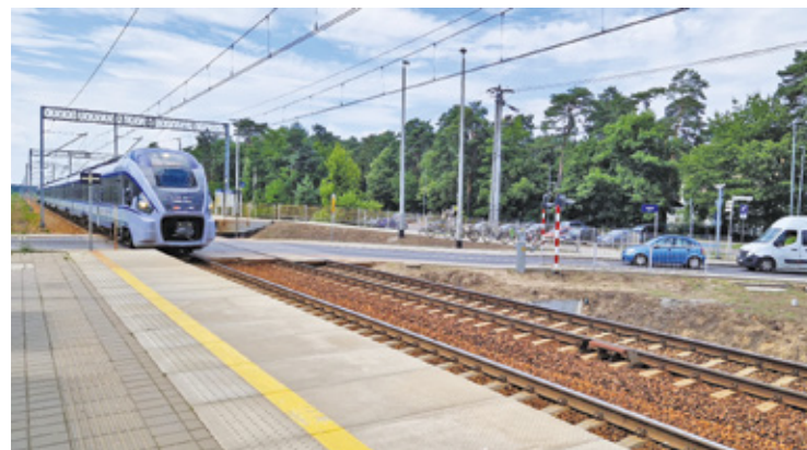
Budowa nowej linii kolejowej, która przetnie miasto (Śródborów) wywołuje wiele emocji i dzieli samorządy
