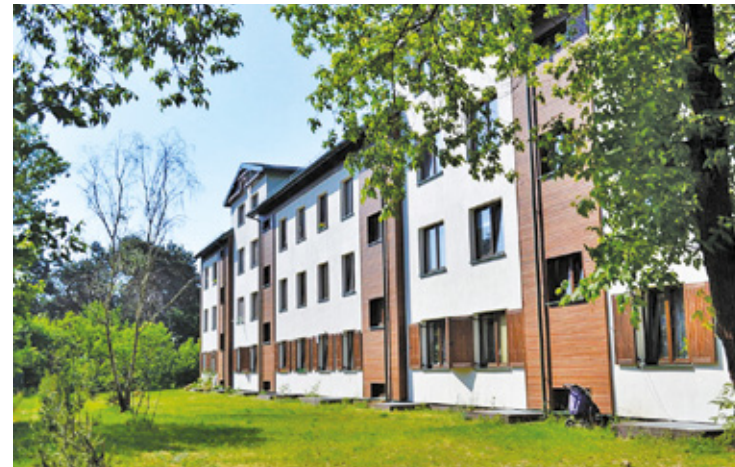
W sąsiedztwie tych bloków powstanie kolejny budynek przy ul. Rejtana
