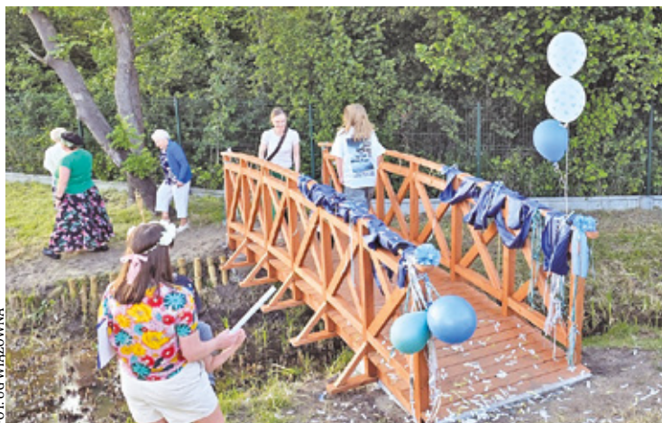
W Dziechcińcu przy stawie zrobiono nową drewnianą kładkę
