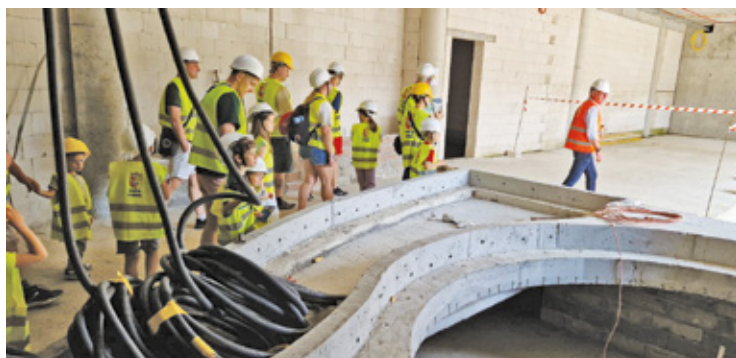
Budowa kompleksu basenowego w Otwocku jest już na bardzo zaawansowanym etapie. W ciągu najbliższych dni rozpoczną się prace nad montażem płyt elewacyjnych, które nadadzą obiektowi ostateczny wygląd
