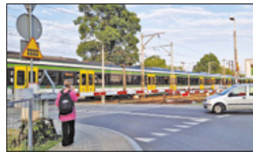
/// Józefów/Otwock - Jest wykonawca budowy 4 torów s. 5
