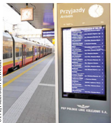
Kolej zaczęła montaż systemu informacji pasażerskiej na stacji w Otwocku
