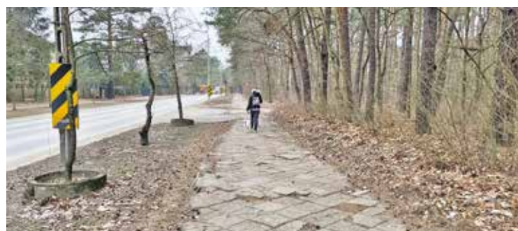
Podczas modernizacji drogi powstaną m.in. dwa rondo i ścieżki rowerowe
