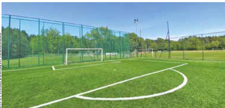
Po modernizacji, boiska piłkarskie mają nową nawierzchnię
