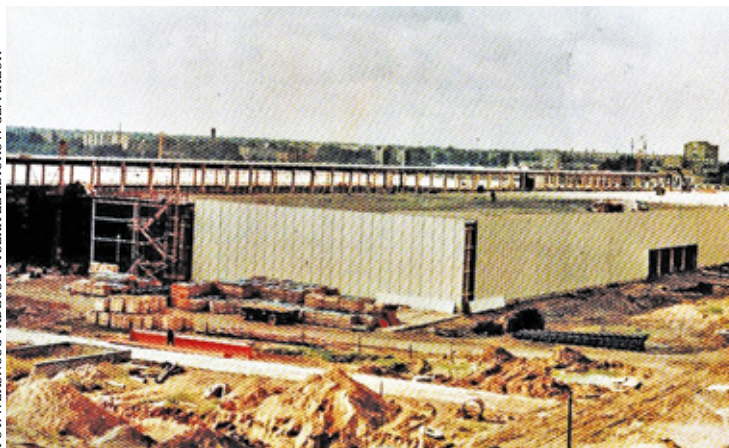
Budowa montowni, zdjęcie z około 1977 r.
