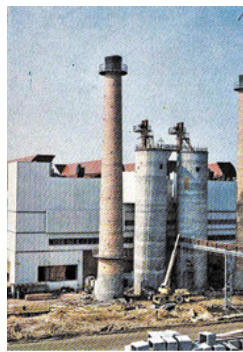
Budowa montowni, zdjęcie z około 1977 r.
