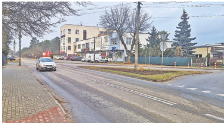
Dwa ronda powstaną na skrzyżowaniach przy ul. Kołtąta i ul. Świderskiej. W ramach projektu powstaną też nowe chodniki, ścieżka pieszo-rowerowa, zjazdy na posesje, odwodnienie oraz oświetlenie
