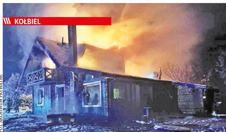
Ogień pojawił się w górnej kondygnacji budynku i błyskawicznie rozprzestrzenił się na kolejne części domu
