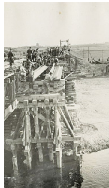
Sufczyn – budowa mostu na Świdrze
