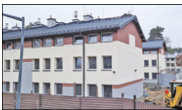
/// Józefów – Budynki komunalne z windami s. 3
