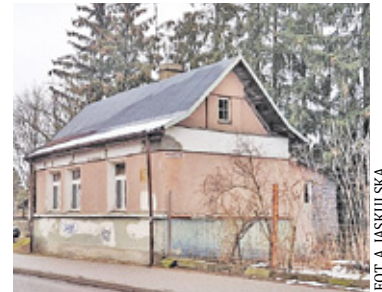
Budynek stacji kolejki wąskotorowej
