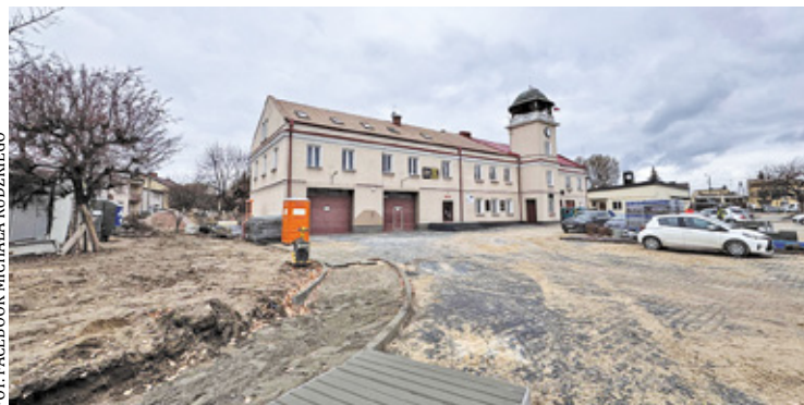
Powstał już między innymi parking przed OSP i pierwszy odcinek kanalizacji deszczowej
