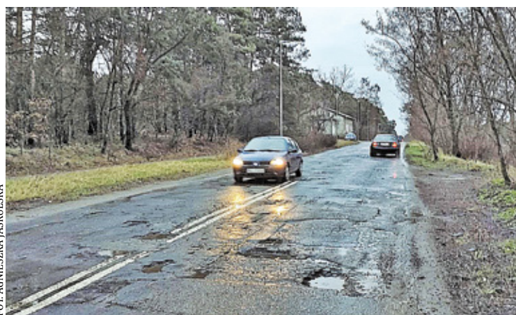
Przebudowa fragmentu wyeksploatowanej drogi ma rozpocząć się na wiosnę w zależności od pogody
