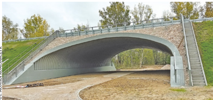
Na koniec całej inwestycji przyjdzie poczekać do końca marca 2025 r.
