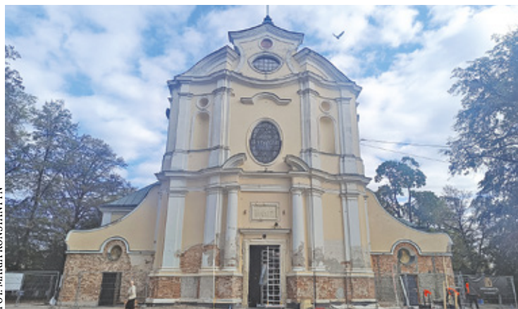
Do końca października mają zostać wykonane prace przy detalach kamiennych
