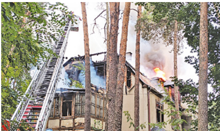
Pożar willi przy ul. Reymonta
