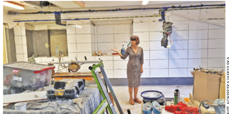
Remont szkolnej kuchni w SP nr 2 w Karczewie
