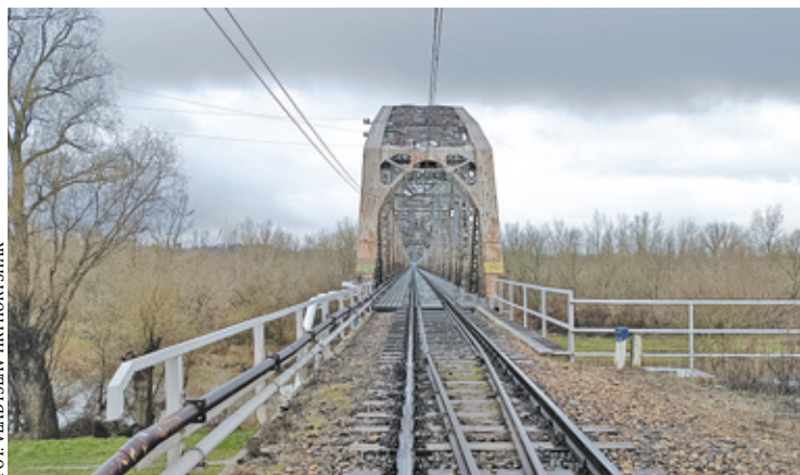
Projekt przewiduje modernizację dwutorowej linii kolejowej na odcinku Glinki – Góra Kalwaria
