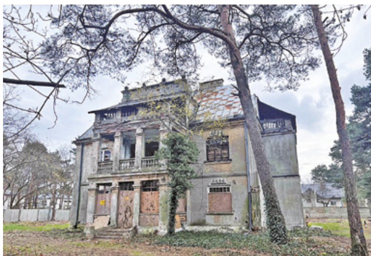
Stan techniczny willi jest bardzo zły
