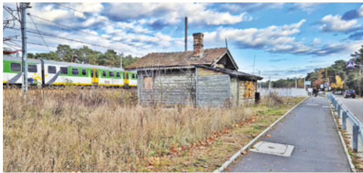
Miasto planuje rewitalizację domu dróżnika
