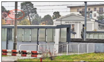
||| Otwock - Nowe kamery w przejściach podziemnych s. 2
