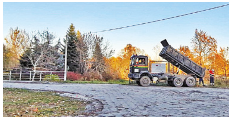
Nowy odcinek drogi łączy ul. Trzaskowskich z ul. Częstochowską
