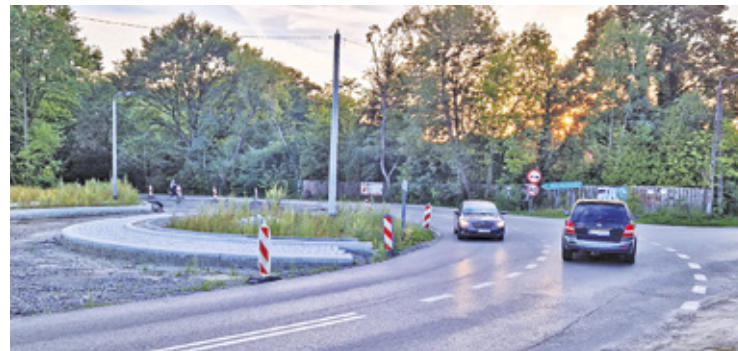
Niedokończona budowa ronda w Gliniance
