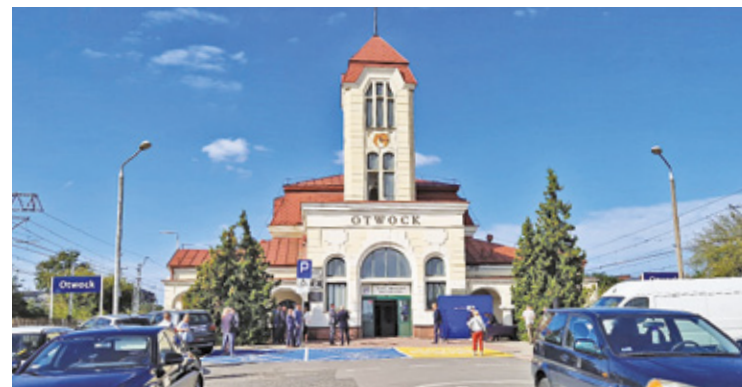
Zabytkowy dworzec kolejowy w Otwocku
