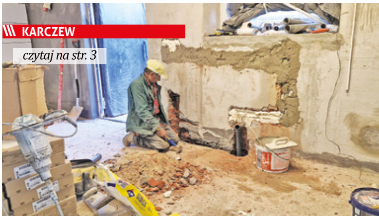
Remont szkolnej kuchni w SP nr 2 w Karczewie
