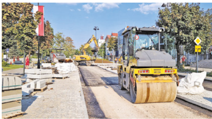
Roboty drogowe potrwają jeszcze kilkanaście dni
