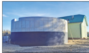
/// Piwonin - Oczyszczalnia na ukończeniu s. 5
