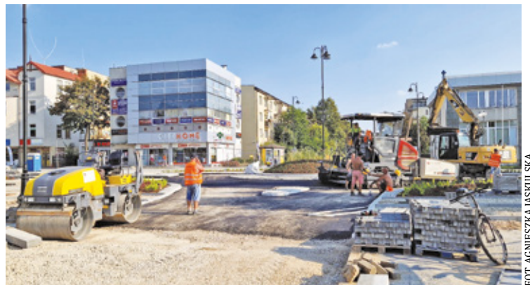
To już ostatni etap przebudowy skrzyżowania na ul. Powstańców Warszawy
