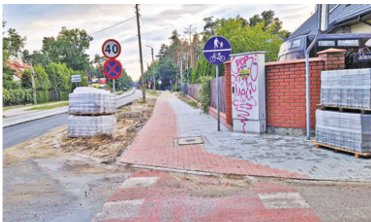
Na ul. Wyszyńskiego trwa budowa m.in. ciągu pieszo-rowerowego z kostki
