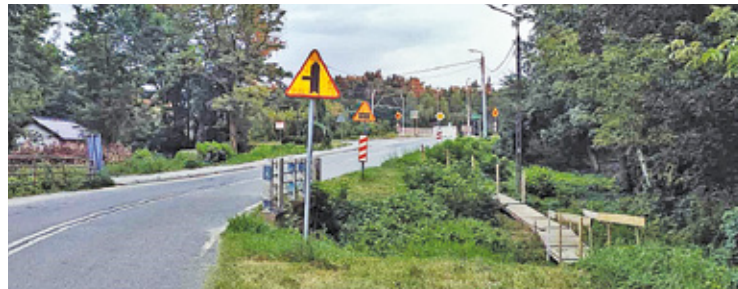
Obok mostu w Pogorzeli powstała już drewniana, tymczasowa kładka dla pieszych i rowerzystów
