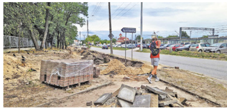
Trwa budowa trasy pieszo-rowerowej na ul. Warszawskiej od ronda przy PKP Otwock do Świdra
