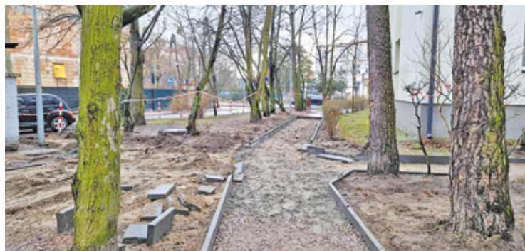
Mieszkańcy osiedli od dawna zabiegali o wymianę starych chodników
