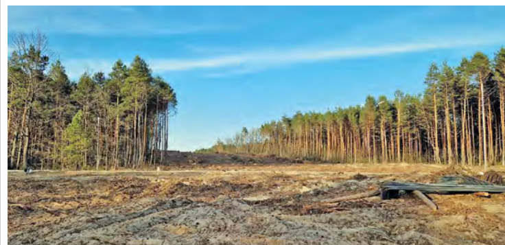
Aktualnie wykonawca przygotowuje teren pod budowę nowej obwodnicy
