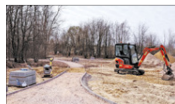
/// Karczew - Ruszyła budowa parku trampolin
