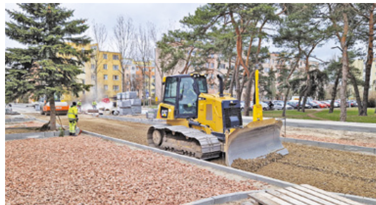
Wykonawca prowadzi roboty na odcinku w kierunku ul. Pułaskiego i ul. Andriollego
