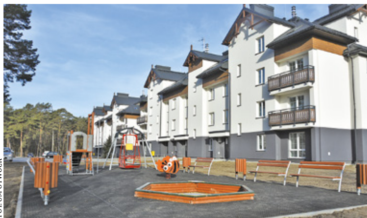
Przy ul. Kochanowskiego powstały dwa czterokondygnacyjne budynki
