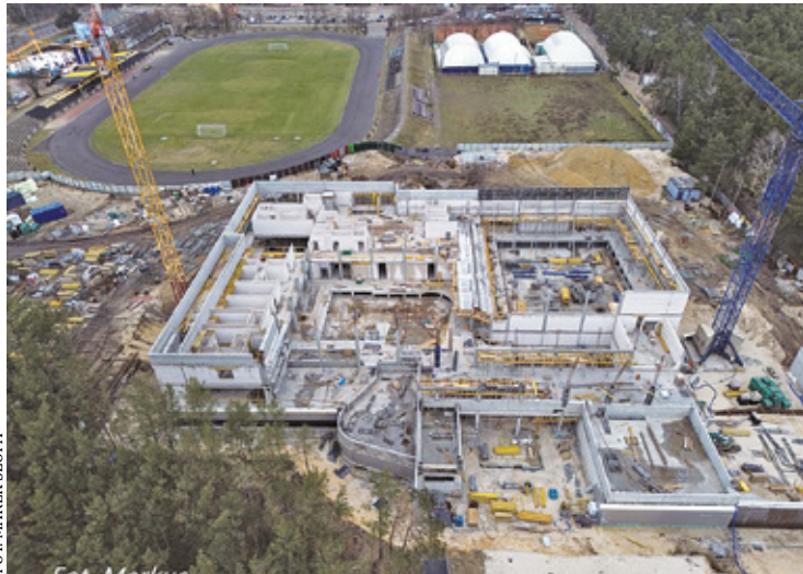
W ramach inwestycji powstanie kompleks sportowy z basenem
