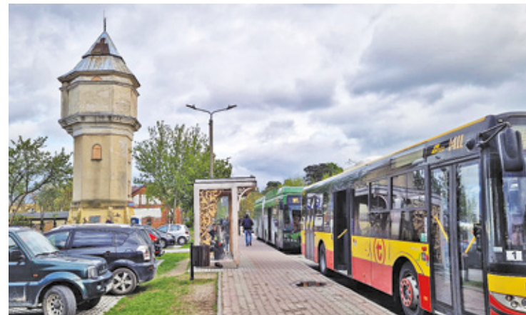
Wieża ciśnień znajduje się przy przystankach autobusowych przy ul. Orlej w Otwocku
