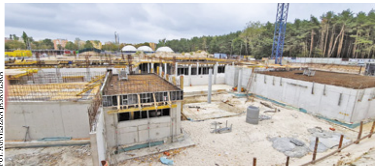
Nowoczesny obiekt powstaje przy ul. Karczewskiej
