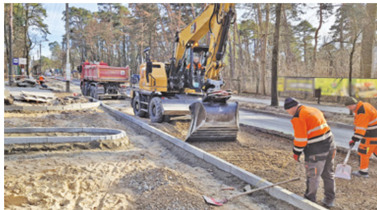
Modernizacja drogi w kierunku Warszawy rozpoczęła się trzy miesiące temu
