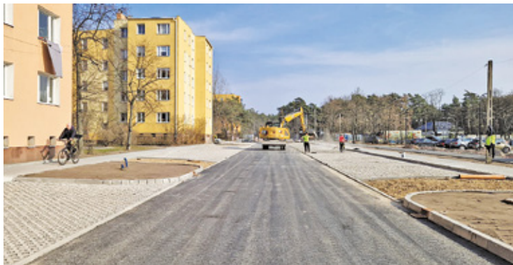
Wykonawca kończy prace na wysokości osiedla i ulicy Sportowej
