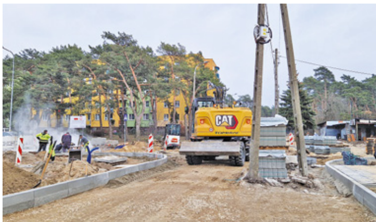
Obecnie wykonawca realizuje roboty na wysokości osiedla i ulicy Sportowej
