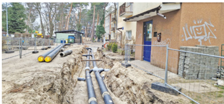
Przy blokach OSM trwa wymiana przestarzałej sieci ciepłowniczej
