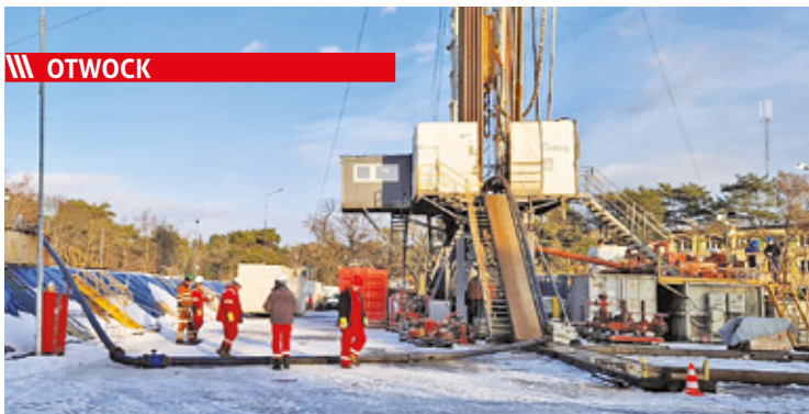
W ubiegłym roku zakończono prace i zabezpieczono ujęcie geotermalne
