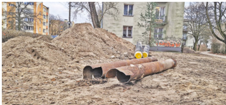
Przy blokach OSM trwa wymiana przestarzałej sieci ciepłowniczej
