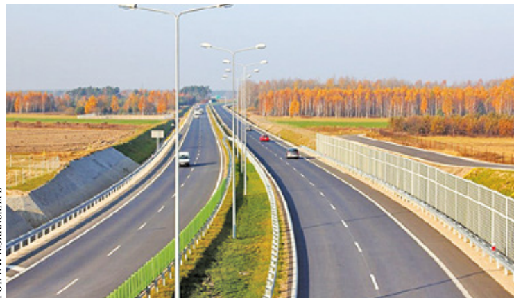
Do przetargu na przebudowę karczewskiej obwodnicy zgłosiło się pięć przedsiębiorstw. Najtańszą ofertę złożyła firma Strabag, która przebuduje trasę za 87,7 mln zł
